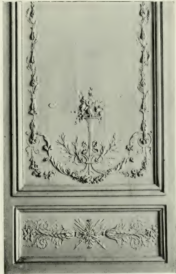
Boiseries dans les bâtiments de la cour des Princes (Ecole d'Application).
